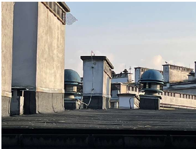
Zdj. 8 Zdjęcie istniejących wentylatorów dachowych do demontażu.
