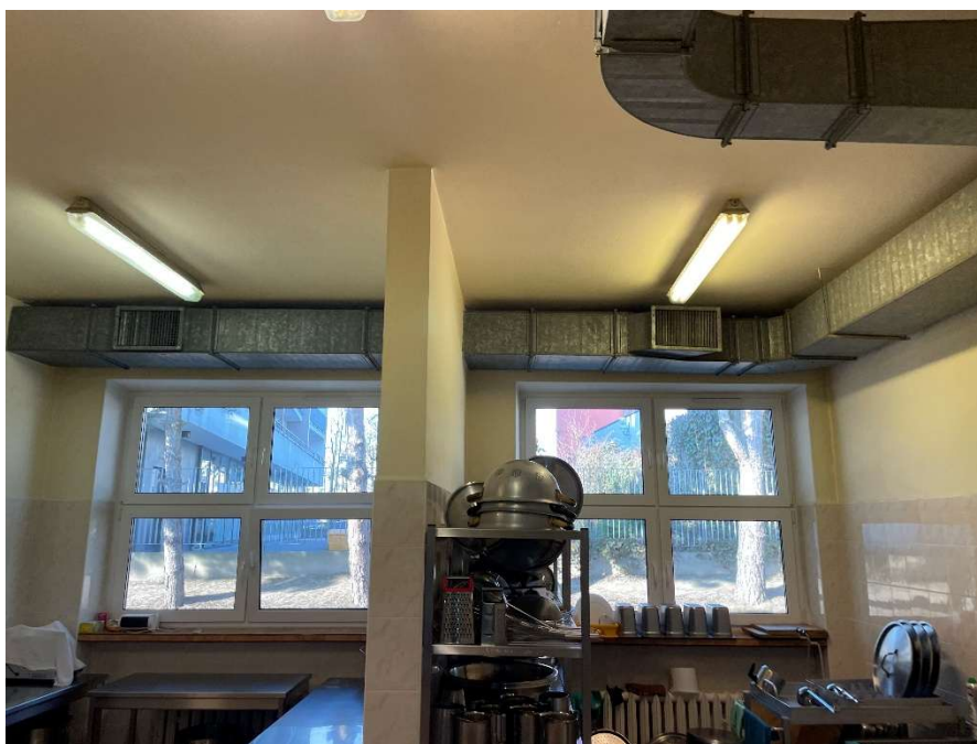
Zdj. 4 Kanał nawiewne kuchnia – do demontażu
