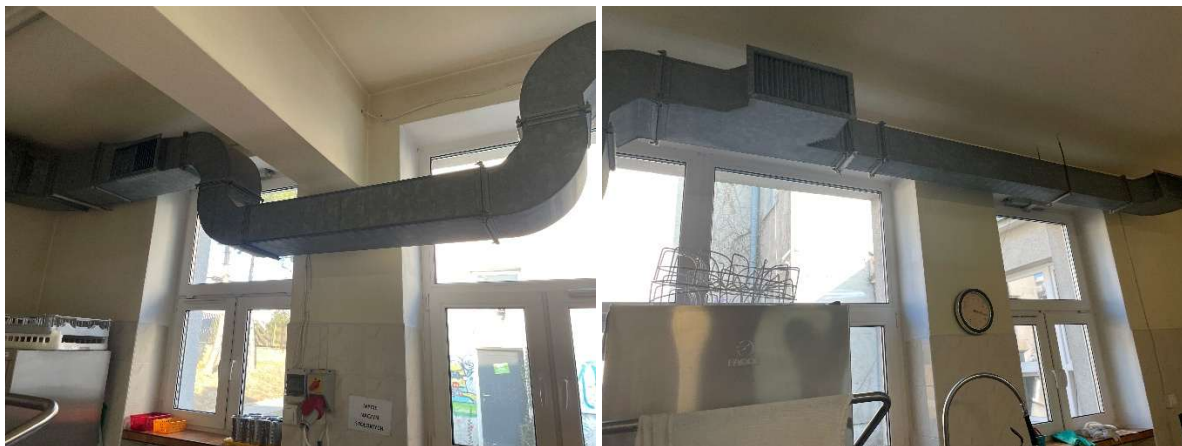
Zdj. 5 Kanał nawiewne zmywalnia – do demontażu
