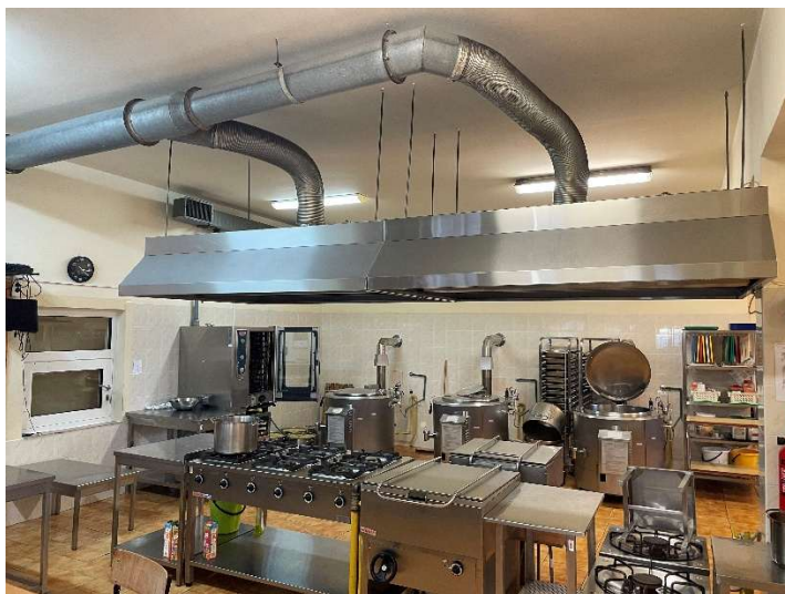
Zdj. 7 Zdjęcie istniejącego okapu kuchennego. Okap nr 1
