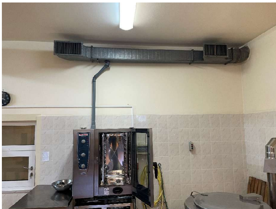
Zdj. 3 Kanał wywiewny kuchnia – do demontażu
